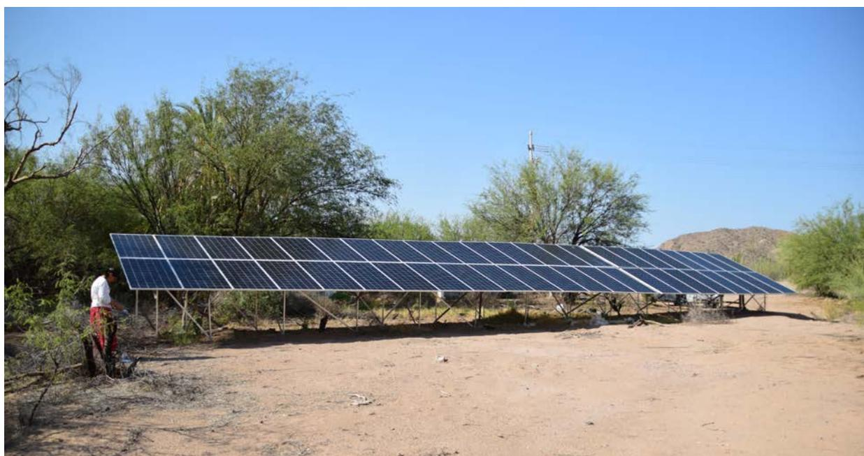
Fig. 1. Arreglo fotovoltaico interconectado a la red de 17.5 kW en el Pozo Coyote a 9 kilómetros de El Desemboque.
